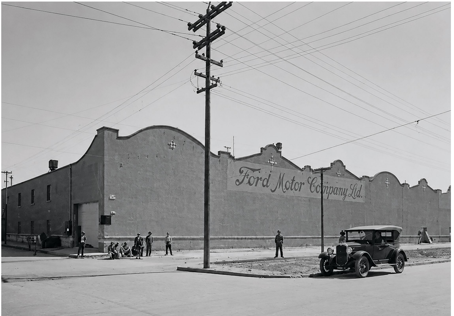
(2) EDIFICIO DE LA FORD MOTOR COMPANY, CIUDAD DE MÉXICO (S. F.-1930~).
